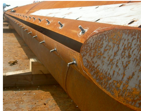
写真② 固定ボルト取付完了
