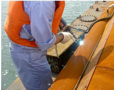
写真① スタッド溶接状況
