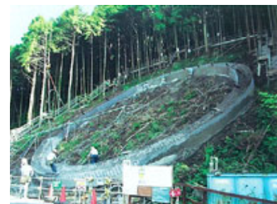
リングビーム施工状況
