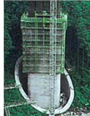
日経コンストラクション 2000年10月27日号表紙 写真 「第二東名高速道路南沢 川橋 (下部工工事)」
