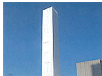
密閉養生状況（煙突）
