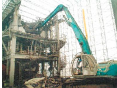
油圧式圧砕（重機）による解体
