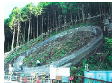
リングビーム施工状況
