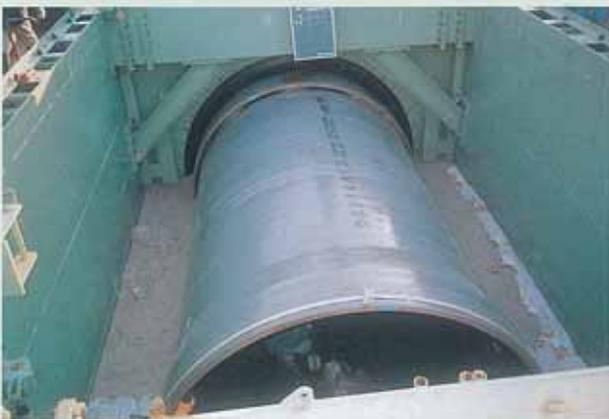
反力板、鉛直火打ち梁 機内FRPM管据え付け完了
